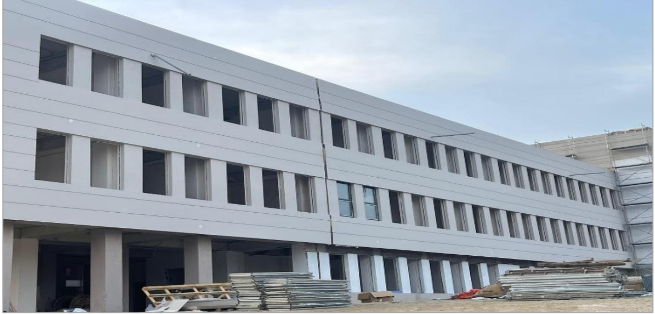
Merkezi Derslik Binasına ait görsel
